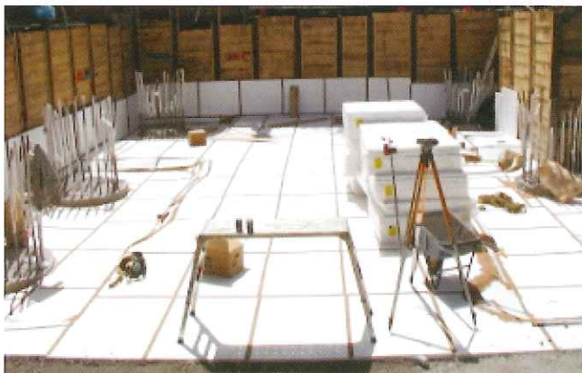
地下鉄からの固体音、振動対策例
