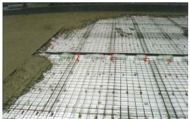
耐水性浮き床施工例
